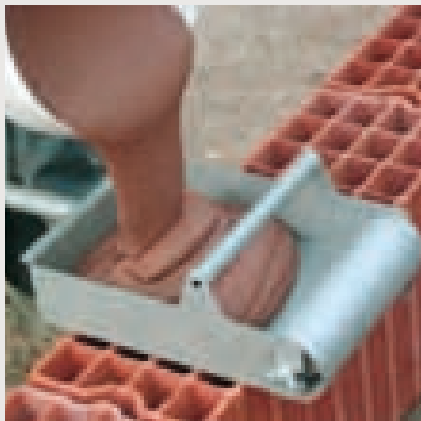
8 - Si le mortier s'est épaissi, il suffit de le malaxer légèrement, sans ajout d'eau, pour le fluidifier à nouveau.
