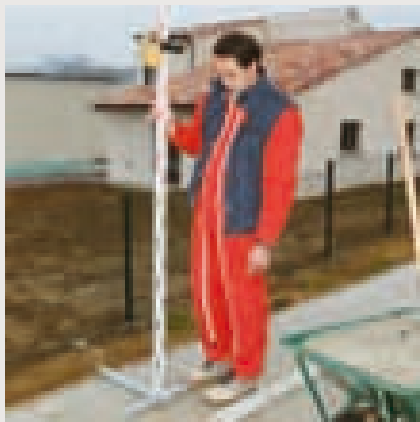
1 - A l'aide d'un niveau laser, déterminer le point haut de la dalle.
