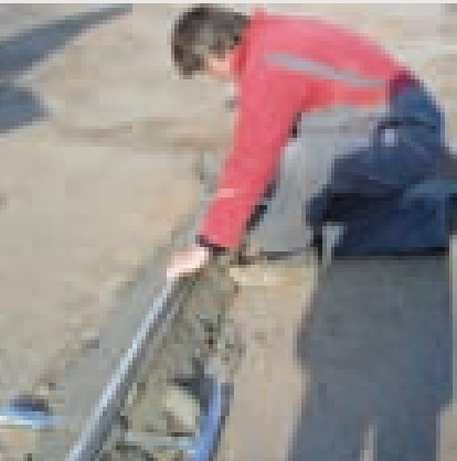
3 - Réaliser l'arase au mortier hydrofuge à l'aide d'une règle. Constituer ainsi une arase périphérique parfaitement de niveau (ép. 2 cm minimum).
