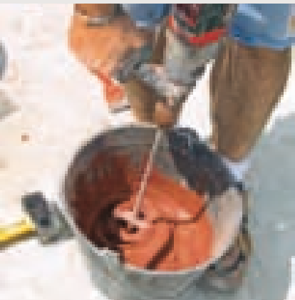
6 - Malaxer mécaniquement un sac de 25 kg. Taux de gâchage : selon indications sur le sac. Durée de malaxage : 3 minutes. Durée d'utilisation : 1h30 à 2h suivant les conditions atmosphériques.
