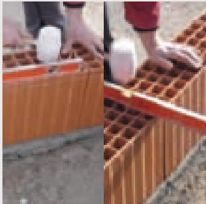
5 - Promener le niveau afin de vérifier et régler le parfait alignement et l'horizontalité des produits dans les deux sens.
